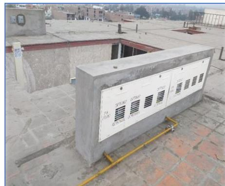
**f) Tubería flexo metálica**
